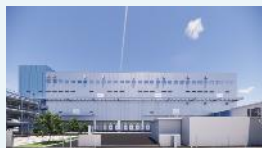
(仮称) 船橋西浦物流センター 2026年10月末竣工予定 延床面積 約2.9万㎡ (予定)
