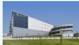
ロジポート多摩瑞穂 2024年6月竣工 延床面積 約16.2万㎡
