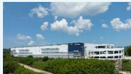
ロジポート福岡粕屋 2024年8月竣工 延床面積 約9.1万㎡
