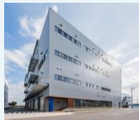
東京東雲物流センター 2024年11月竣工 延床面積 約1.3万㎡
